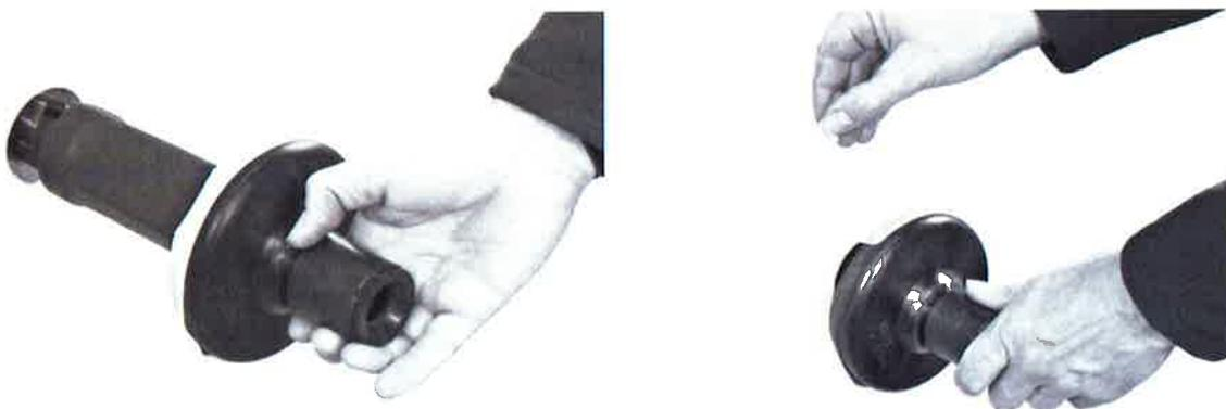
Abbildung 2. Einführen der Mauerdurchführung in die Bohrung (links) und Abziehen der Schutzfolie vom Butylband des Gummiflansches (rechts) (Herstellerfotos).
