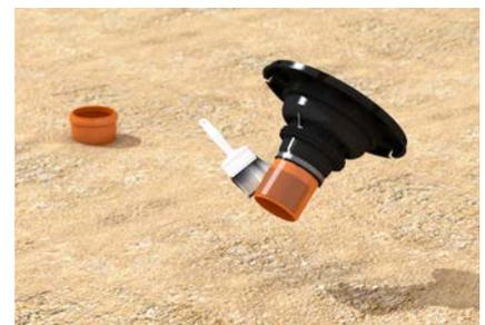
KG-Rohr mit Gleitmittel schmieren
