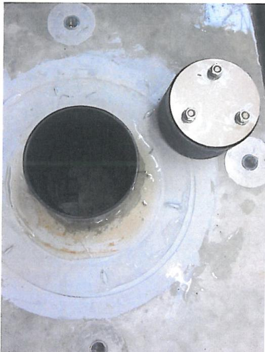
Abbildung 3: Futterrohr und Innenabdichtung
