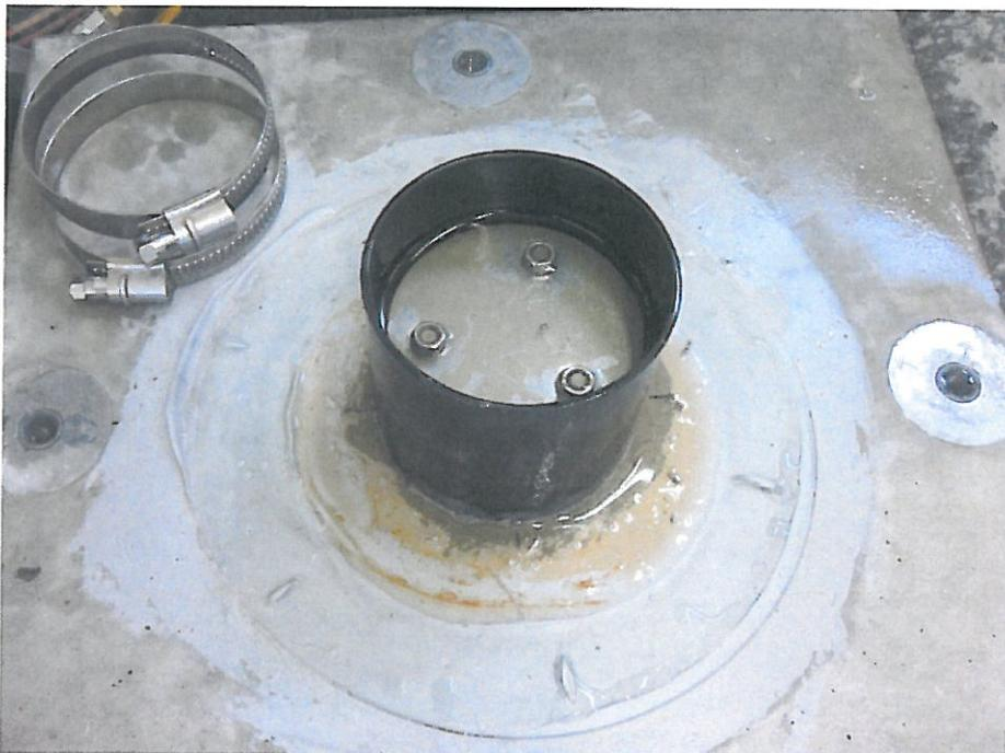
Abbildung 1: Futterrohr mit Rohrrinnenabdichtung
