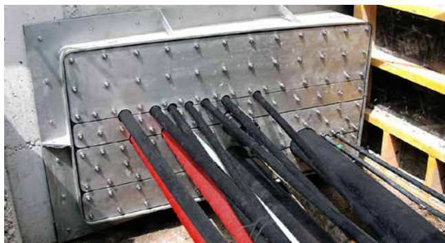
Brida rectangular separada con múltiples entradas
