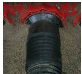
Conexión de tuberías corrugadas con tecnología de retracción en frío HSI150 D1x110 KS WR
