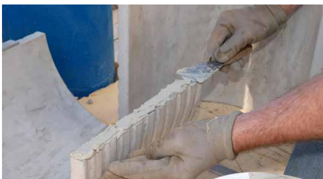
FZRG350/300 con masilla del kit de montaje MSET FZRG
