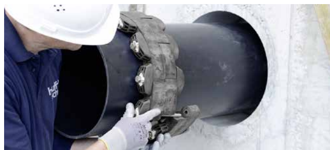
GKD400 – colocación de los segmentos
