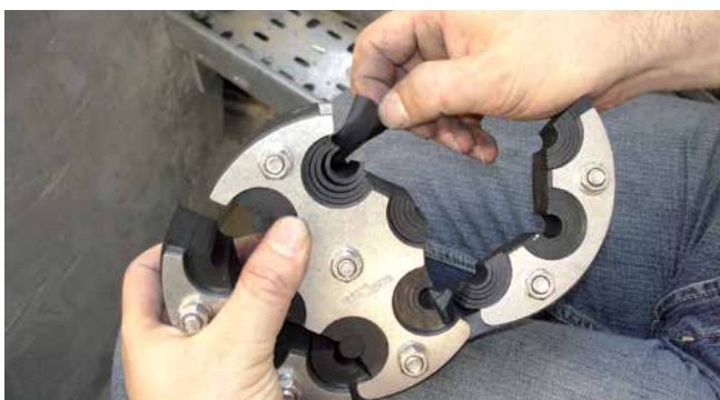
HRD150 SG 6x8-36 5 – lajiste flexible al diámetro del cable
