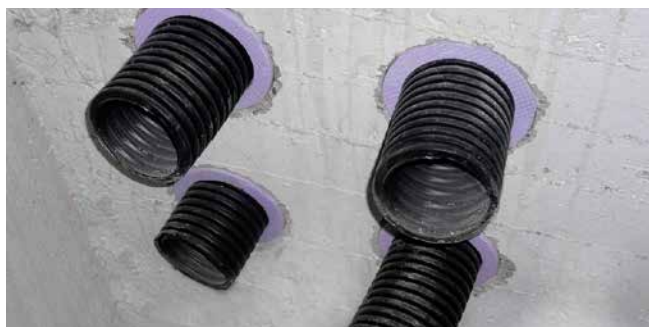
Vista del interior del edificio (anillo aislante)
