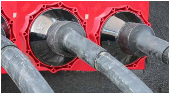
Canalización de estaciones: Cable de baja tensión sellado con HSI150 D1x80 WS
