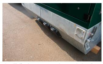
Die Andübelflansche HSI 150-DFK wurden vom Stationshersteller bereits vormontiert und mit Verschlussdeckel HSI 150-D blind verschlossen. Zur Montage der Flansche auf den Metall-Gehäuseboden wurden Blechschrauben verwendet (entsprechend der Materialstärke des Gehäusebodens, bauseits gestellt).
