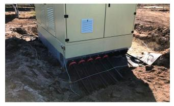
Je nach Leistung der einzelnen Stationen und der dafür erforderlichen Anzahl an Kabeln, werden mehrere Kabeleinführungen benötigt. Durch die kompakte Bauform der Andübelflansche können bis zu 7 Stück in Reihe am Gehäuseboden der Station montiert werden. Die Montage der mitgelieferten Systemdeckel HSI 150-D3/58 sowie die Abdichtung der Kabel erfolgen vor Ort.
