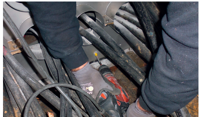
Montaż uszczelniającego kołnierza gumowego za pomocą masy uszczelniającej Sikaflex.
