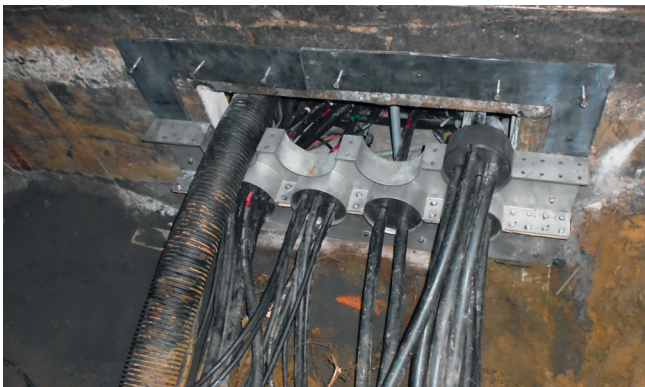
Kołkowanie flanszy do ściany za pomocą wkrętów ze stali nierdzewnej.
