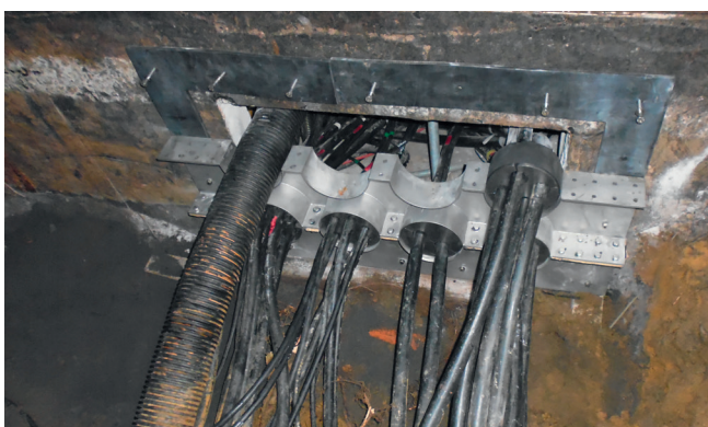
Montaggio graduale delle piastre di rinforzo con tasselli prolungati e viti in acciaio inox.
