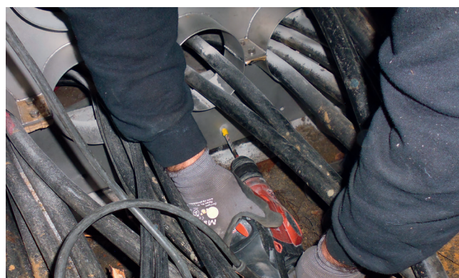
Guarnizione superficiale incollata alla parete con la massa sigillante Sikaflex.
