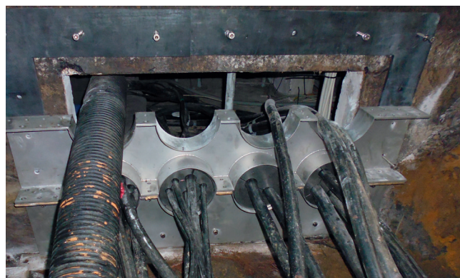
Guarnizione superficiale incollata alla parete con la massa sigillante Sikaflex.
