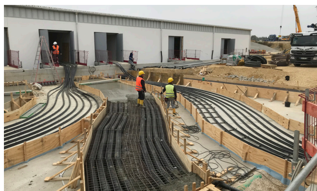
Betonowanie połączenia rury osłonowej między nowym budynkiem a istniejącymi obiektami.
