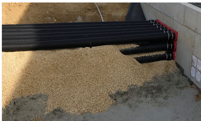
Rury osłonowe zamontowane do przepustów HSI 150.
