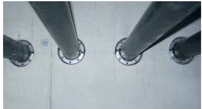
HSD125 1x75 b20 A2/EPDM55 empty conduit connection
